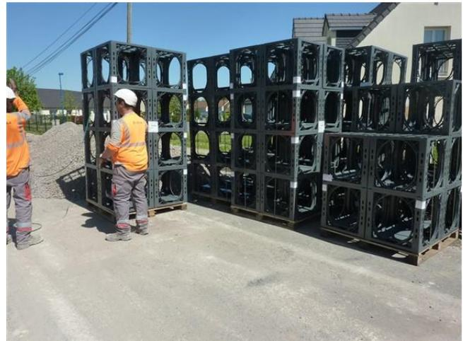
C'est un trou de 30 m de long sur 6 mètres de large et de 3,5 mètres de profondeur qui a été creusé. Quarante-vingt-dix camions de terre ont été retirés et évacués (en haut à gauche) afin de pouvoir mettre en place des caissons en composite qui figurent sur les autres photos. Ces caissons seront recouverts d'un mètre de matériaux divers. S'agissant de caissons creux, cette fosse pourra recueillir une grande quantité d'eau de pluie.
